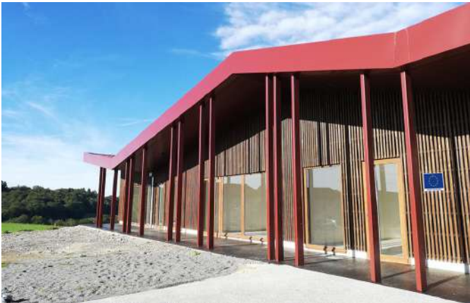
Halle commerciale - Corrèze, Saint-Just-le-Martel
