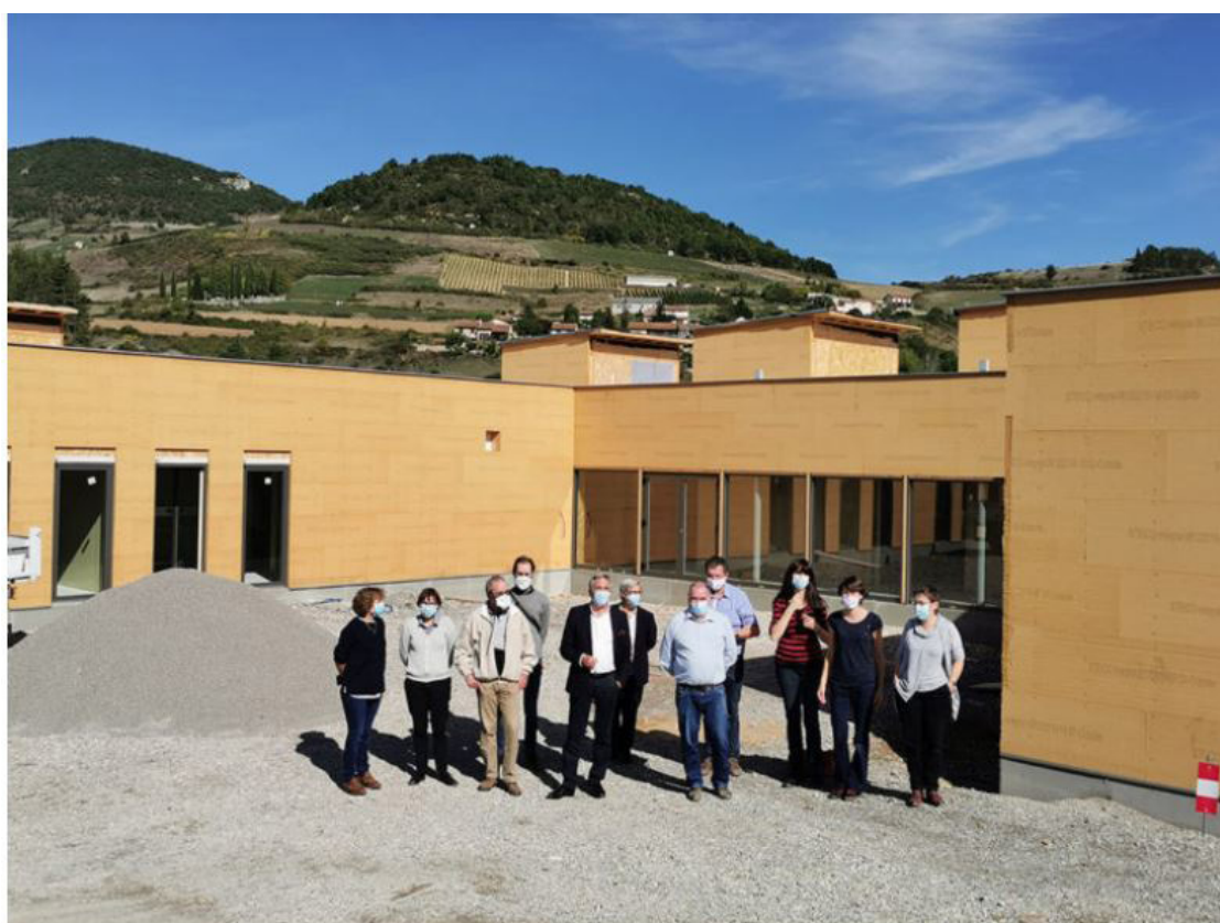
Les élus et acteurs du projet de la filière bois font un point sur le chantier. ©Millavois.com
