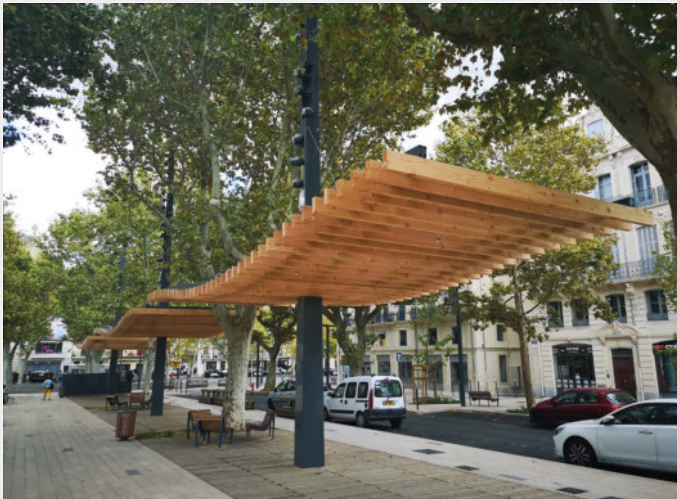
Place Jean Jaurès à Béziers - Ingérop a réalisé la mission de MOE Conception-Réalisation, co-traitant avec l'architecte-paysagiste Pena Paysages, le fontainier Diluvial et l'éclairagiste Cobalt Lumière.
